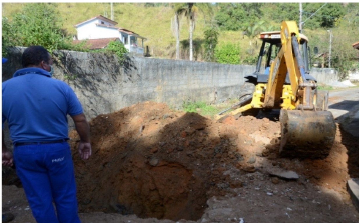
Prefeitura realiza obra emergencial na estrada do Taquari. (8/7)
