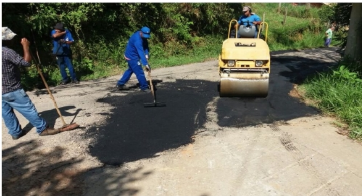
Equipes tapam buracos em via com antipoeira, no distrito de São Francisco Xavier - Foto: PMSJC
