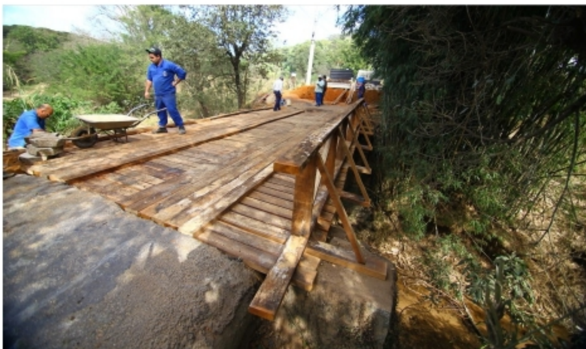
Recuperação de ponte vai garantir mais segurança aos pedestres e motoristas - Foto: Claudio Vieira/PMSJC
