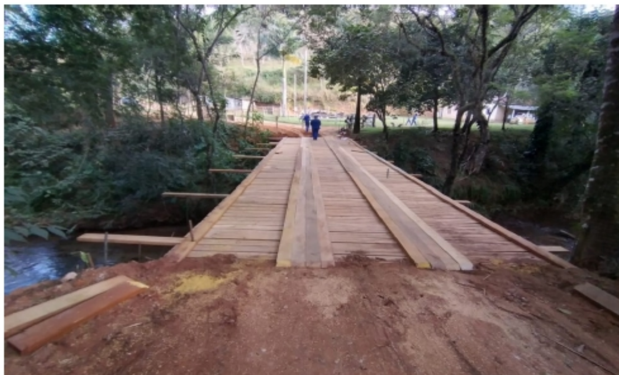
Prefeitura faz manutenção em estradas e pontes de SFX. (21/5)
