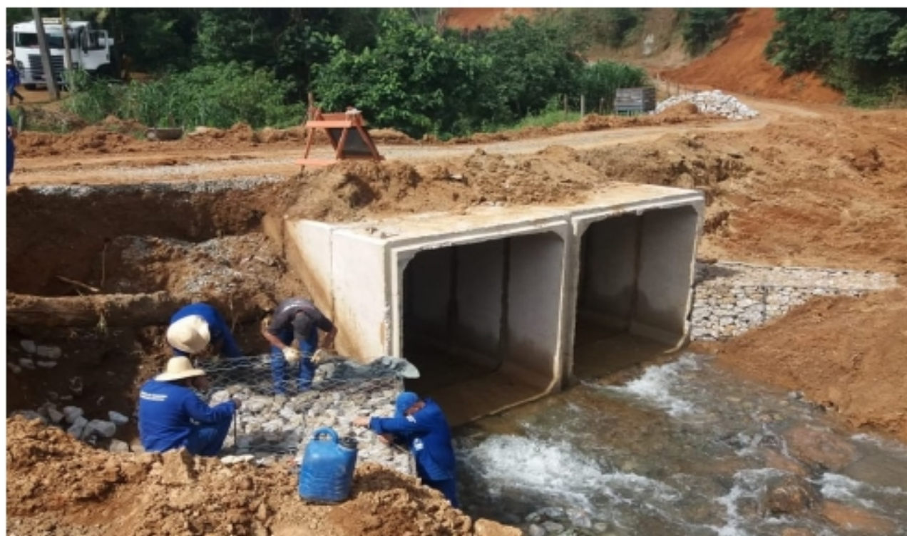
São Francisco Xavier ganha nova ponte na estrada do rio Manso. (5/12)
