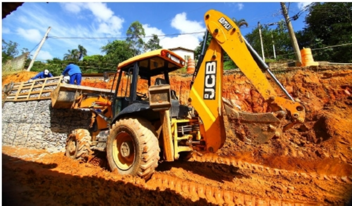
Funcionários da Prefeitura iniciaram recuperação de rua da zona norte que sofreu erosão - Foto: Claudio Vieira/PMSJC
