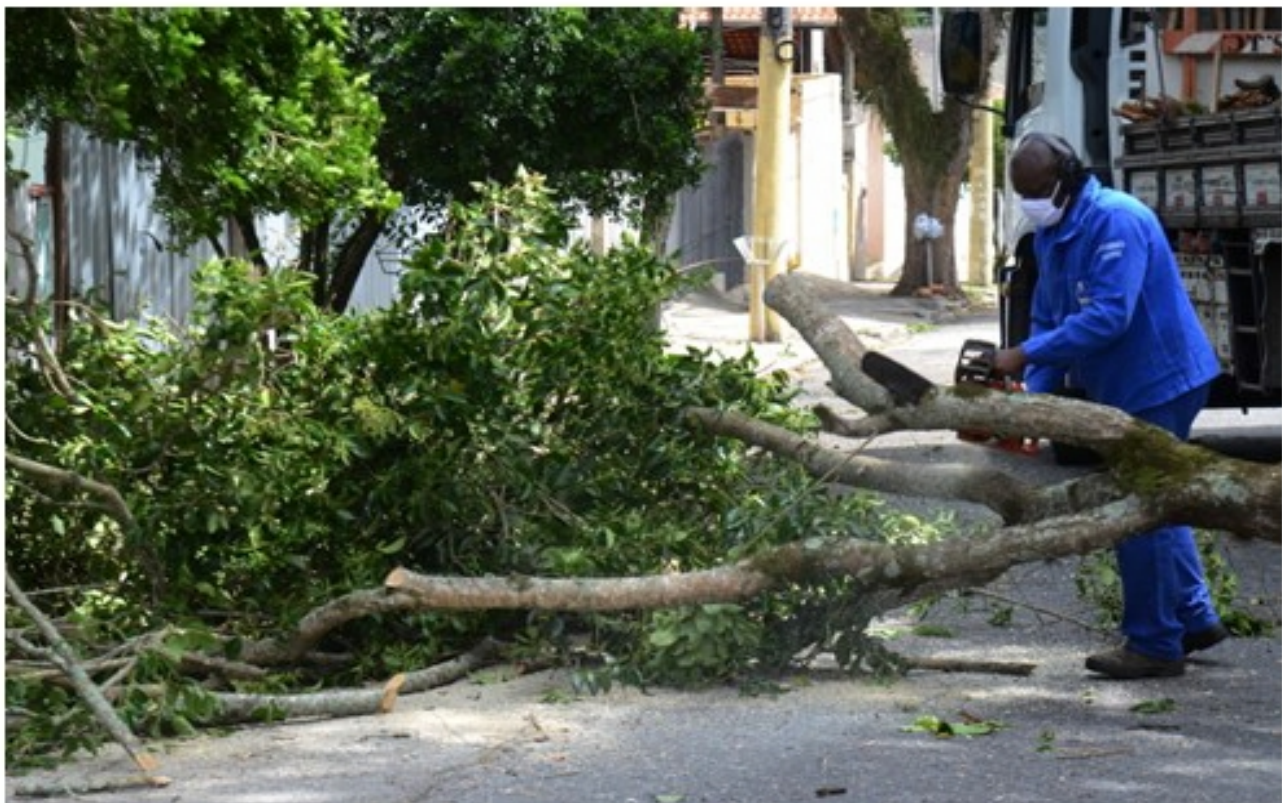
Trabalho emergencial de retirada de árvore na Rua Carvalho de Araújo. (26/10)
