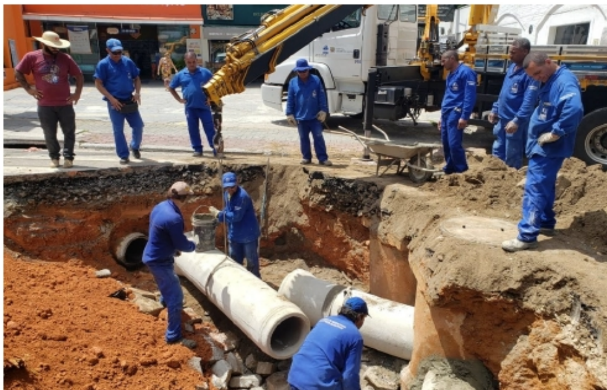
Prefeitura faz obra emergencial em menos de 24 horas. (10/2)
