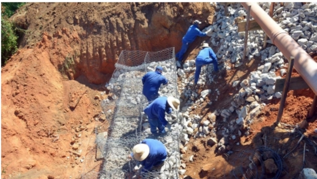
Funcionários da Prefeitura durante manutenção em galeria de águas pluviais do Jardim Del Rey, na zona sul; objetivo é conter erosões - Foto: Charles de Moura/PMSJC
