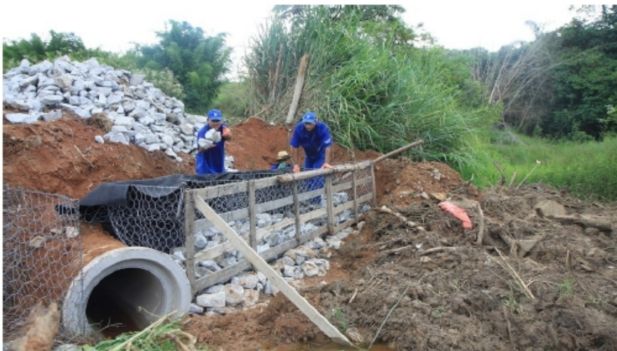
Para a recuperação da estrada entre o Novo Horizonte e Majestic, está sendo utilizado o sistema de gaiolas de gabiões - Foto: PMSJC
