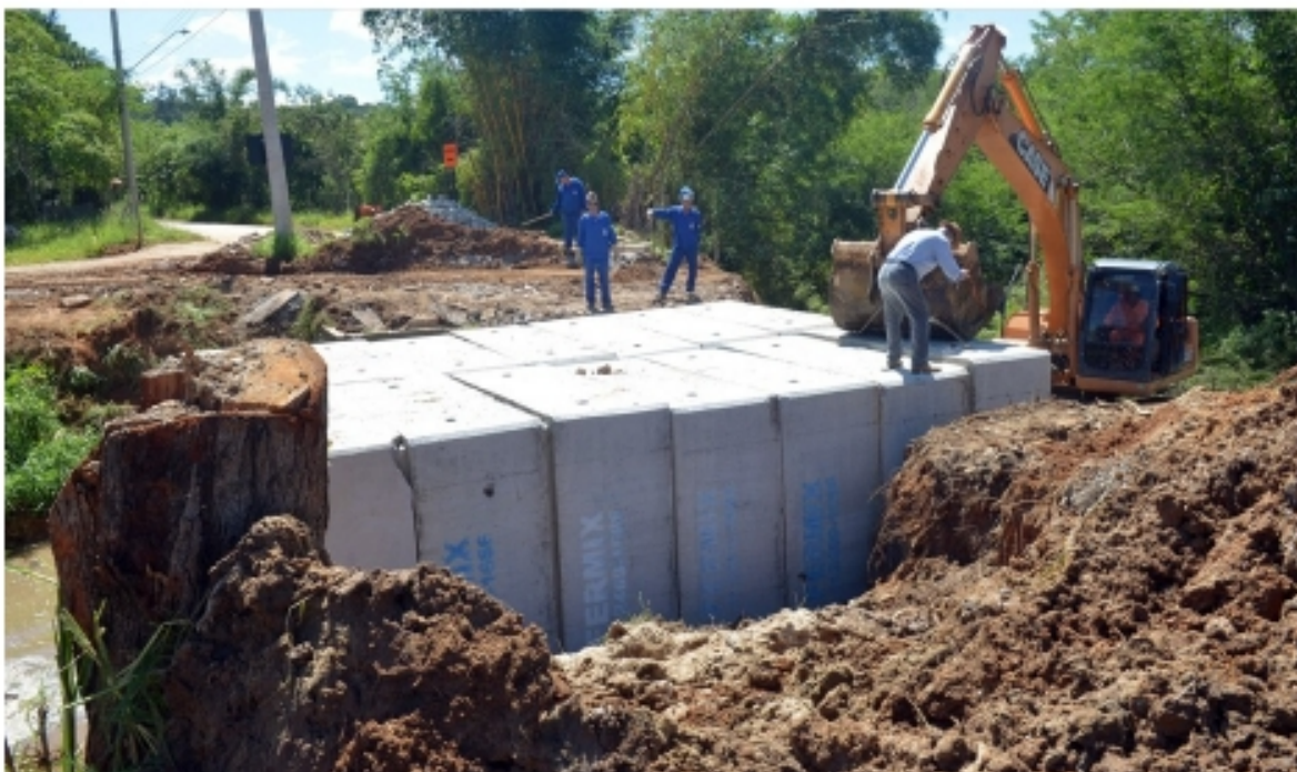
Implantação de tubulações de concreto na ponte da Estrada Frederico Ozanan; ações vão garantir maior segurança aos motoristas - Foto: Charles de Moura/PMSJC
