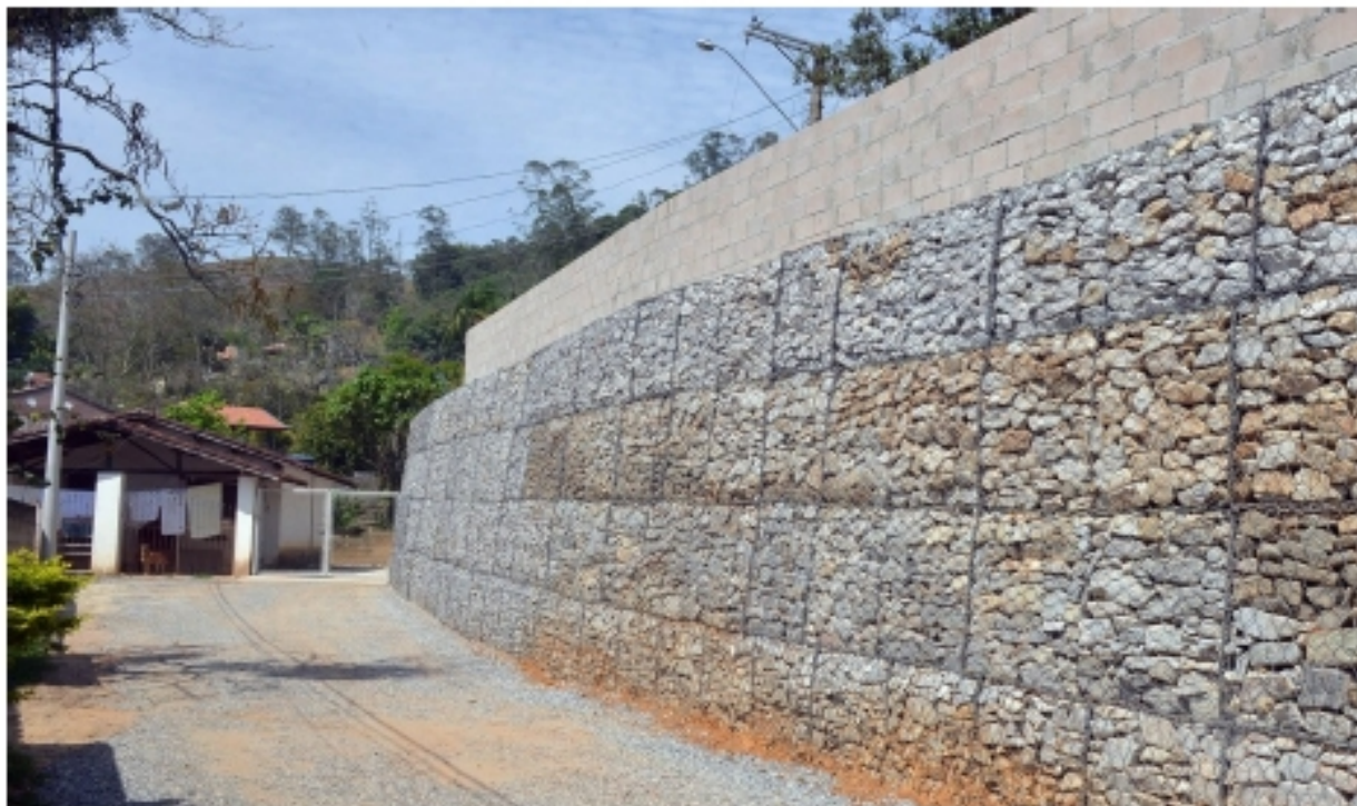
Rua Dona Nega, na zona norte, recebeu cuidados e melhorias para evitar novos deslizamentos de terra e conter erosão - Foto: Charles de Moura/PMRJIC
