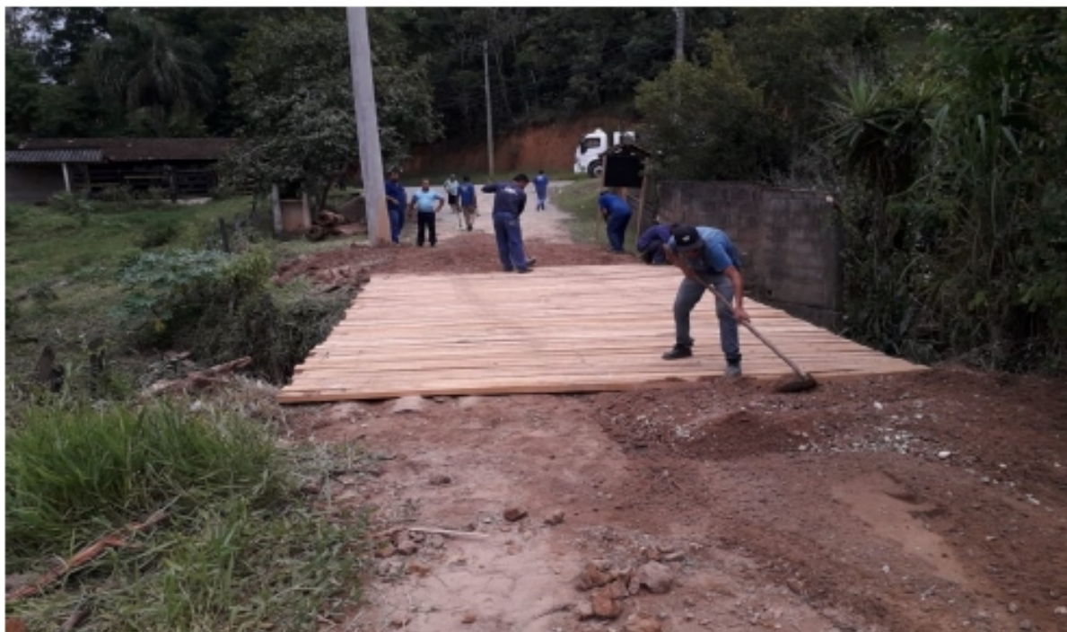
Ponte na zona norte é recuperada e já está liberada para o tráfego. (25/1)
