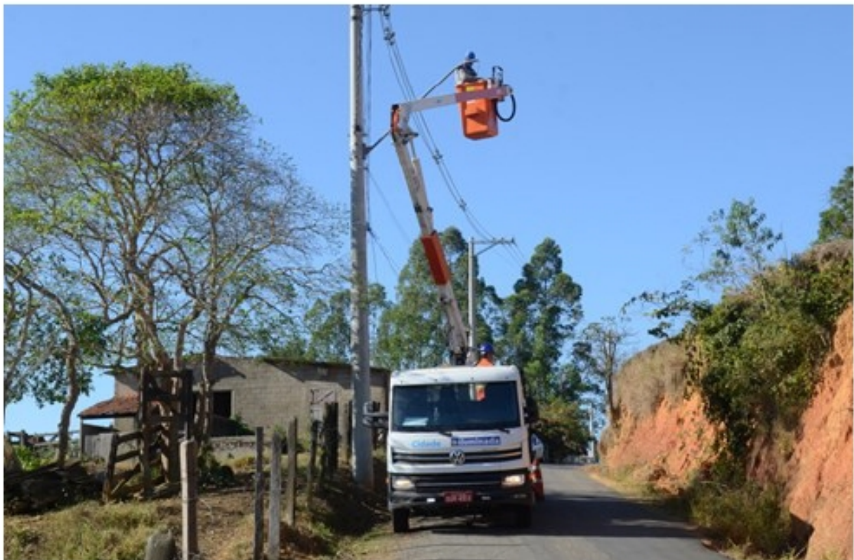
Instalação de lâmpadas LED no Recanto do Caetê / região norte. (22/7)
