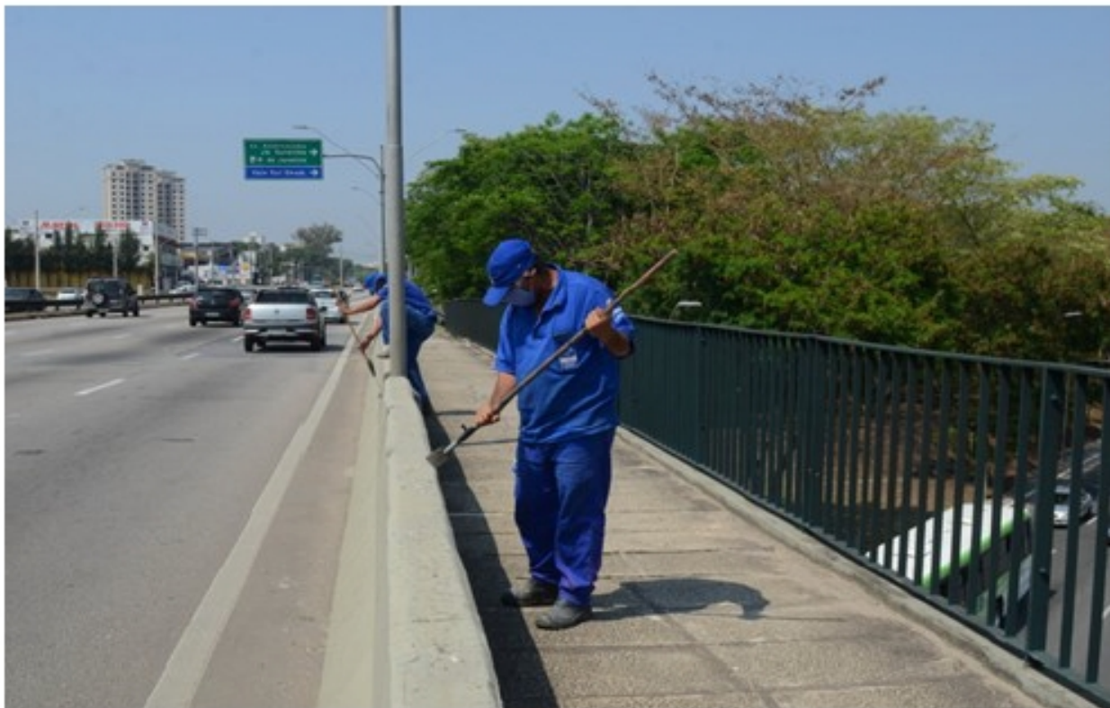
Pintura do Viaduto Kanebo. (30/9)
