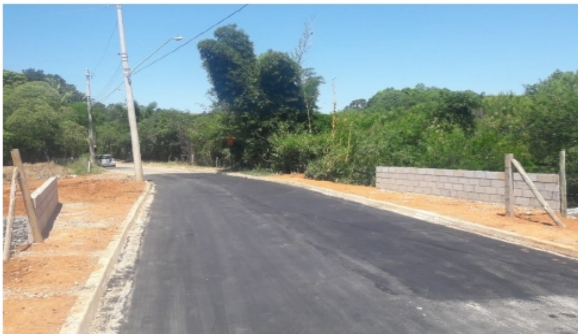
Ponte de estrada da região leste ganha reforço, asfalto e mão dupla. (1/2)
