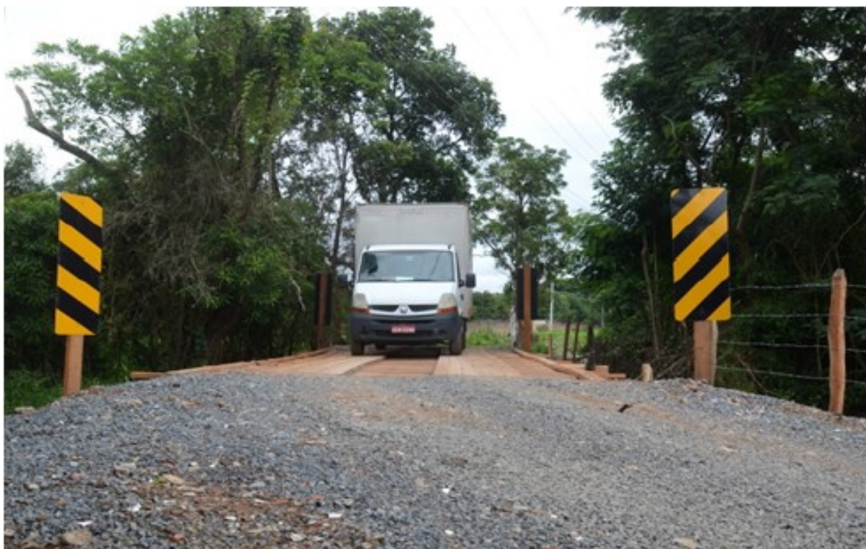
Reconstrução de ponte de madeira no Jardim Nova República. (18/11)
