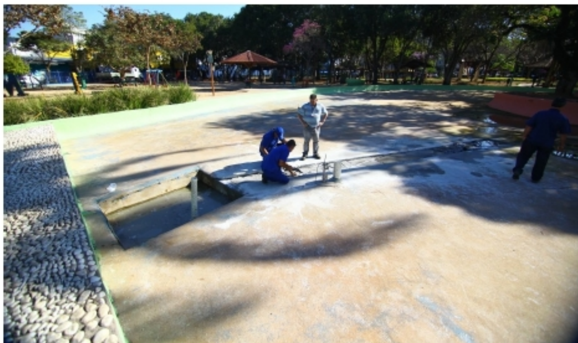
Funcionários fazem manutenção em rede de água do Parque da Cidade: boas práticas garantem a economia - Foto: Claudio Vieira/PMSJC
