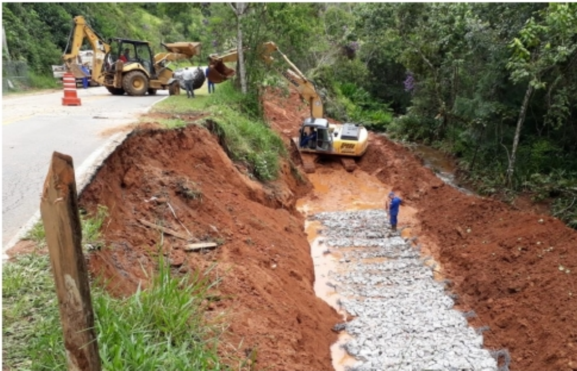
São Francisco tem contenção de erosão na Estrada Pedro Davi. (6/2)
