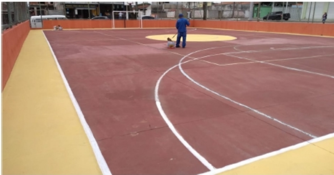
Funcionário da Prefeitura pinta quadra da praça El Shaday, no Jardim Colonial, na zona sul; serviço foi intensificado em toda a cidade - Foto: PMSJC
