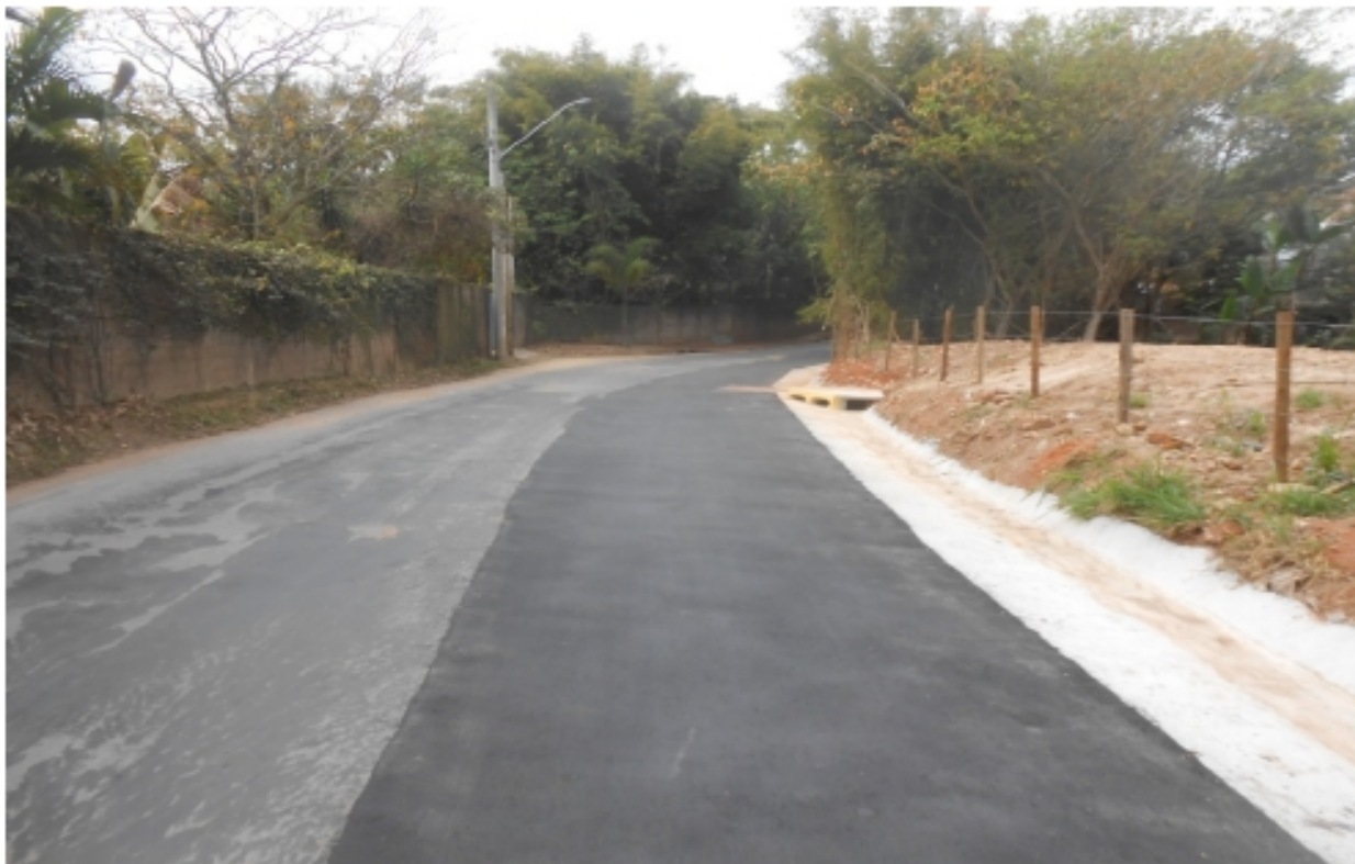
Contenção de erosão e construção de calha de concreto no bairro Torrão de Ouro. (10/9)
