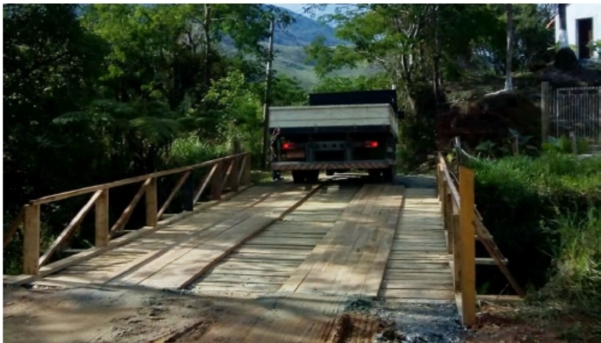
Caminhão passa por ponte totalmente recuperada pela Prefeitura na zona norte, mais segurança para motoristas e pedestres - Foto: PMSJC
