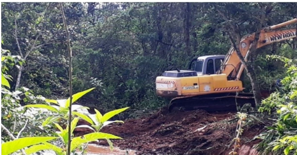
Contenção de erosão às margens do rio do Peixe vai evitar danos na Estrada Municipal Pedro David, garantindo mais segurança aos motoristas - Foto: PMSJC
