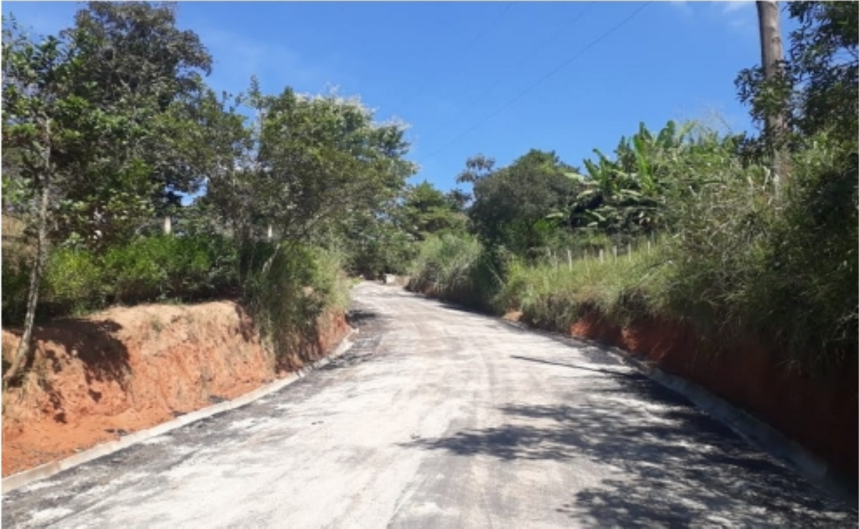
Fresa de asfalto melhora condições de tráfego em rua do Capuava. (30/4)
