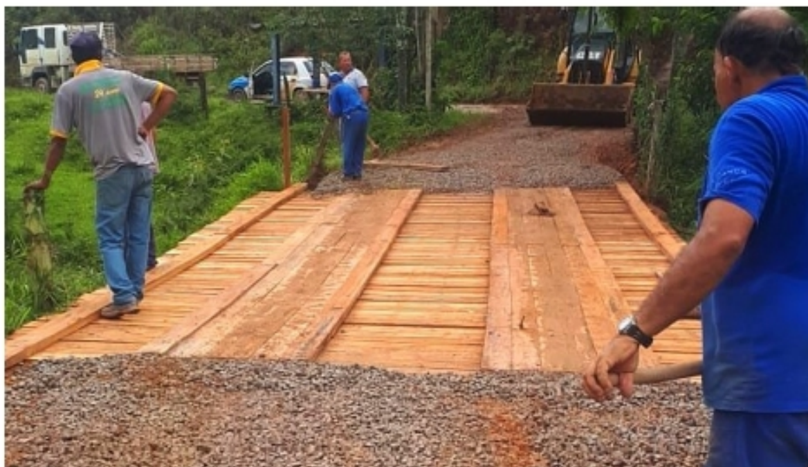
Equipes da Prefeitura trabalhando na ponte sobre o rio das Cobras; é a 4ª ponte da zona norte recuperada nos últimos dois meses - Foto: PMSJC
