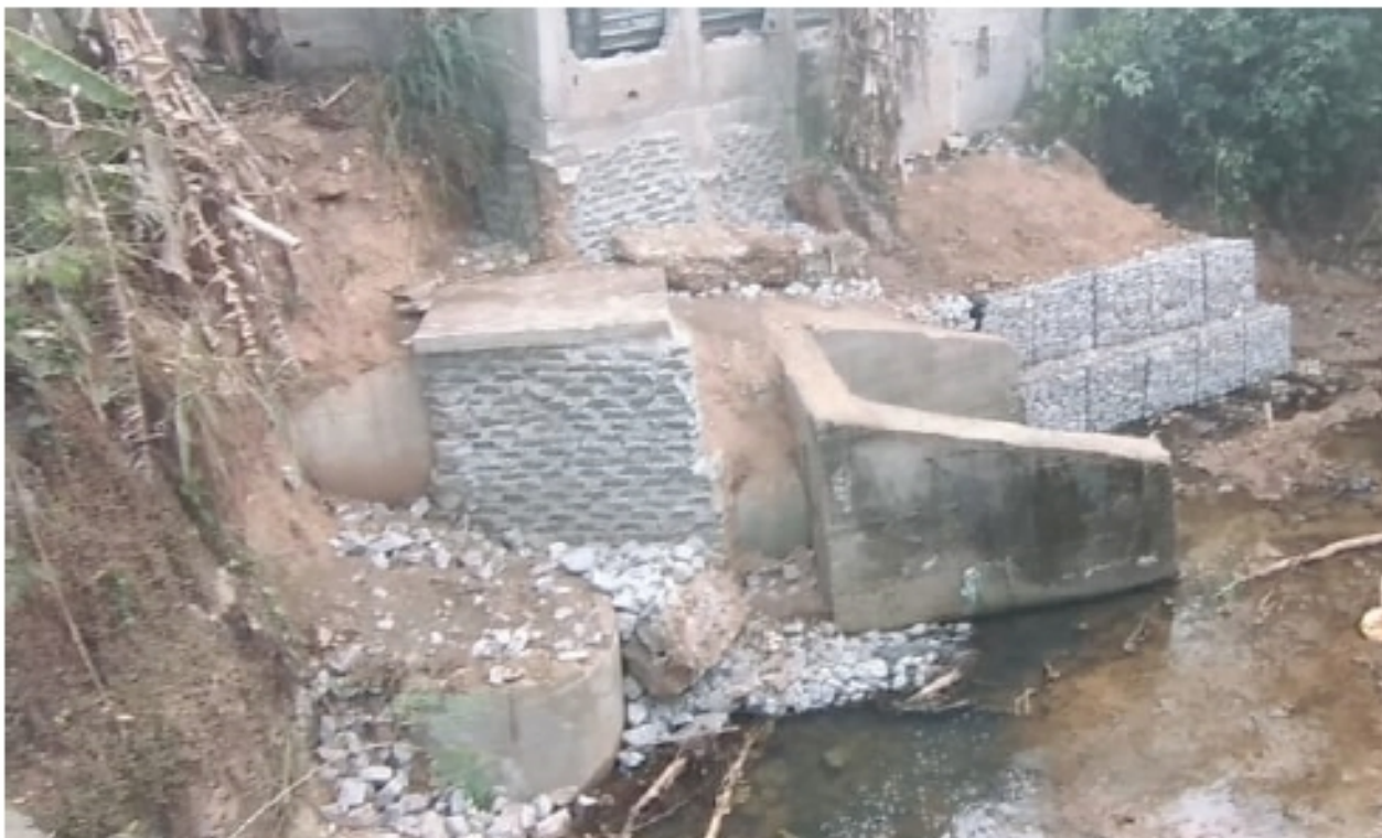
Recuperação de GAP e contenção de erosão / Parque Novo Horizonte. (5/8)
