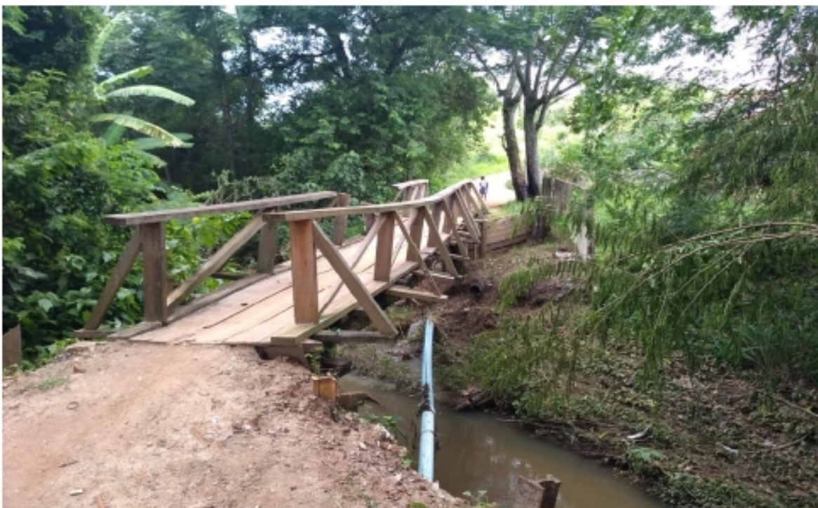
Manutenção na passarela de madeira do Bom Retiro termina na sexta-feira. (29/1)
