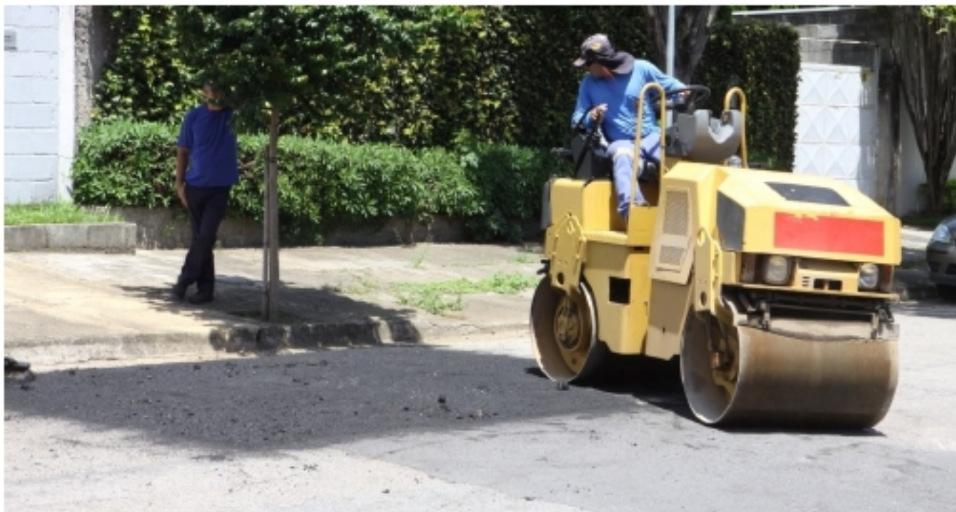
Funcionários da Prefeitura utilizam rolo compressor para compactar solo e tapar buraco - Foto: Beto Faria/PMSJC
