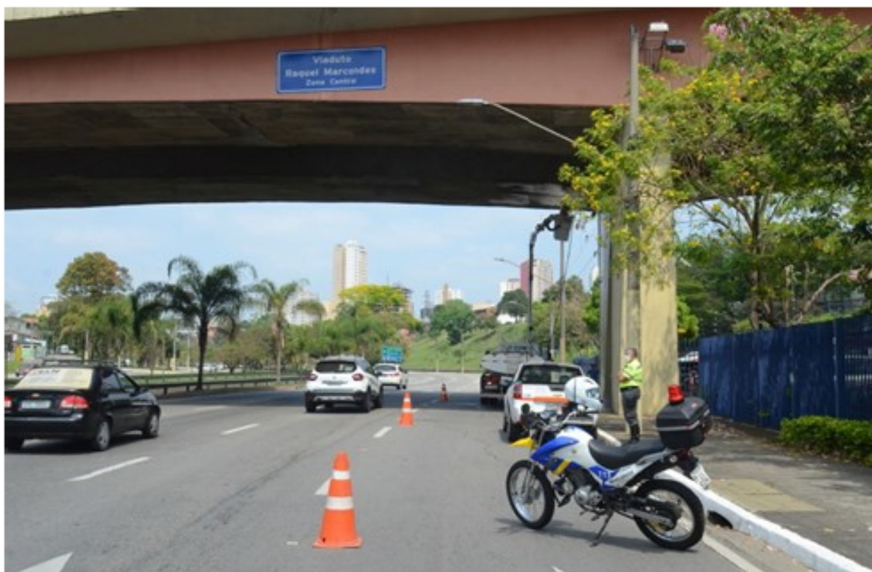
Lavagem do Viaduto Raquel Marcondes. (29/9)
