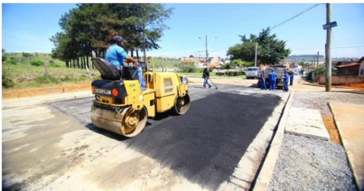
Asfalto sendo implantado na nova ligação entre o Pousada e o Mariana 1, na zona leste: segurança e acesso facilitado - Foto: Claudio Vieira/PM SJ
