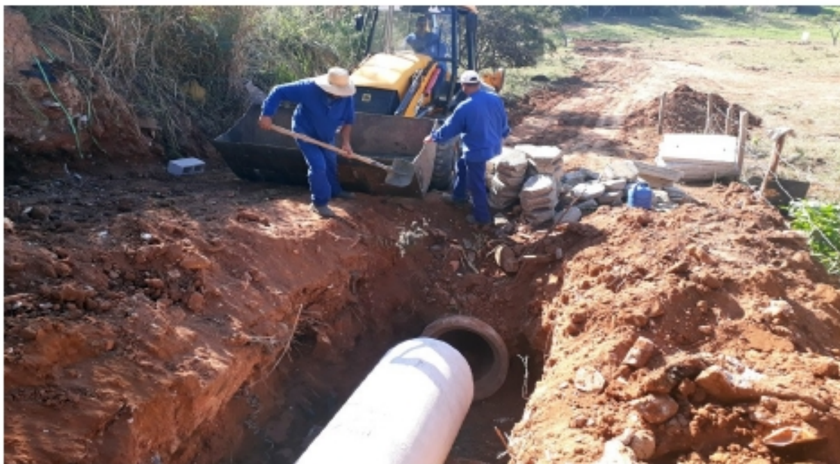
Funcionários trabalham na ampliação de galeria para conter erosão no Jardim del Rey - Foto: PMSJC
