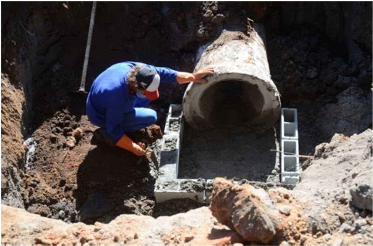
Obra de drenagem na Rua Rio Madeira / Jardim Pararangaba. (22/7)
