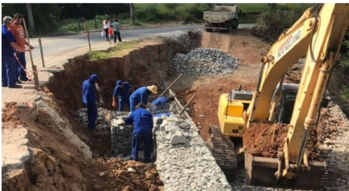
Funcionários da Prefeitura implantam gabião para conter erosão no bairro Vila Cândida - Foto: Divulgação
