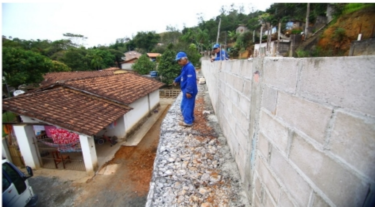
Em outra frente de atuação, a Prefeitura reconstruiu o muro e a calçada, já que existia risco de desabar - Foto: Claudio Vieira/PMSJC
