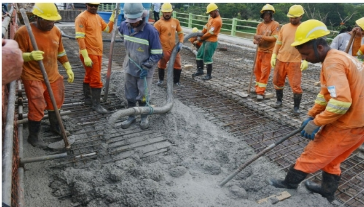
Trabalhadores concretam o trecho da ponte para recuperar o pavimento - Foto: Charles de Moura/PMSJC
